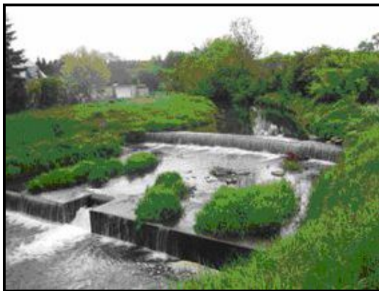
Abb. – Wasserfälle bei Stotzheim – (Aufnahme 9.5.2015).
