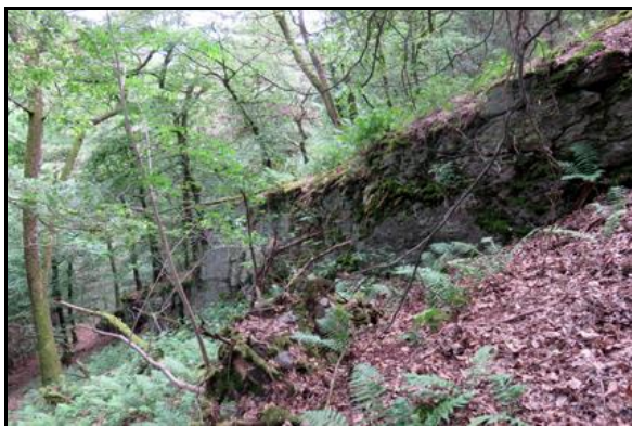
Abb. – Oberhalb verläuft eine weitere Mauer bergaufwärts.
